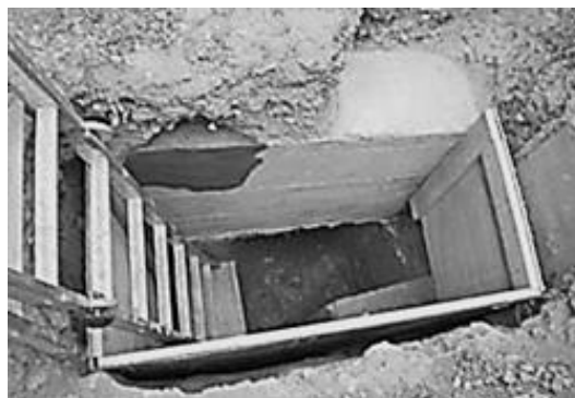
Figura 2 – Preparo civil para a realização do ensaio
